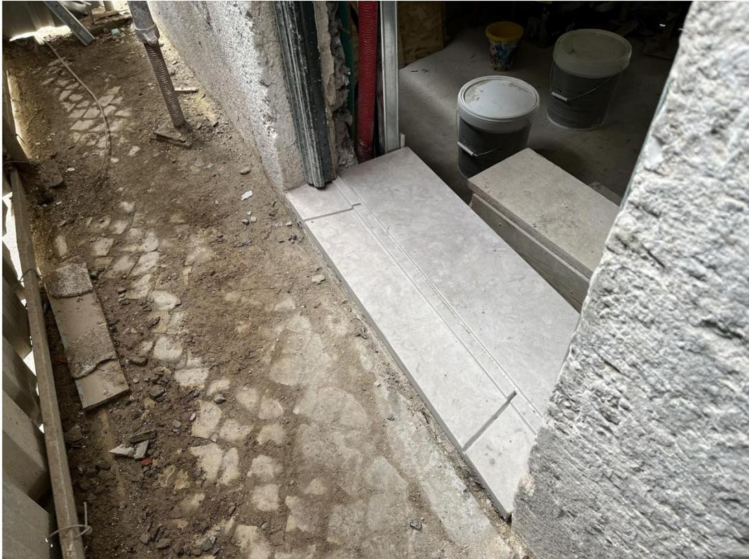
與此同時，建築團隊根據裝修設計規範開始進行鋅制屋頂和外牆板的工作。此外，我們在 3 月份開始為各個部分的所有窗戶和門安裝石材窗臺。值得注意的是，窗戶是在工廠車間生產和預裝的。
