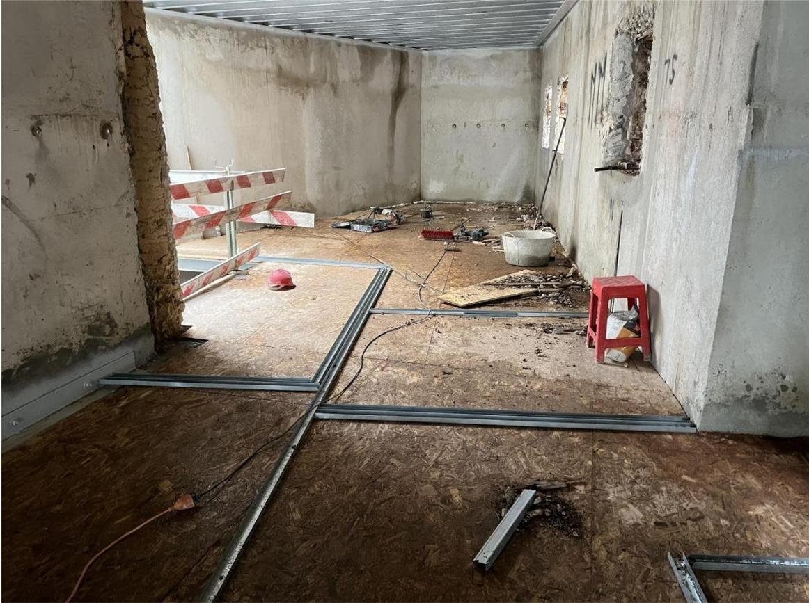
3 月，在完成 1 楼和 2 楼的钢结构安装和面板铺设后，施工团队开始拆除临时钢结构，但主立面的部分除外，这些部分被保留以继续支撑外墙。
